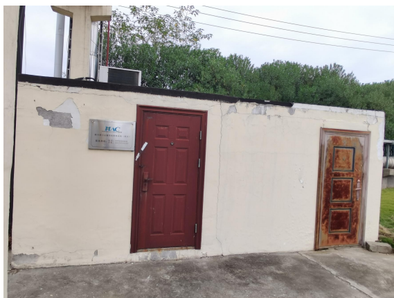
废水在线监控及污水计量房
