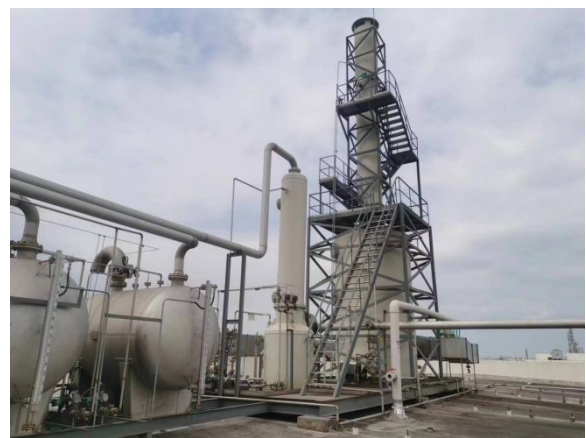
513 车间排放口 DA019
