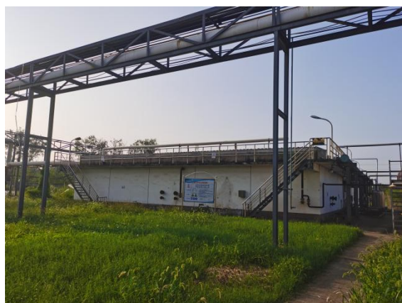
综合废水站（二期）
