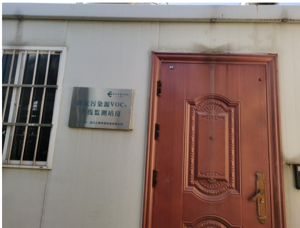
废气在线监控
