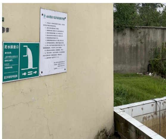
行政楼北雨排口 DW002
