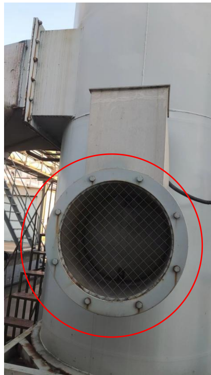
RTO 装置应急新风口，日常封闭状态，不补新风
