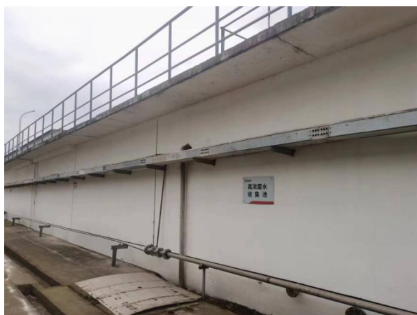
1000m 3 高浓废水收集池
