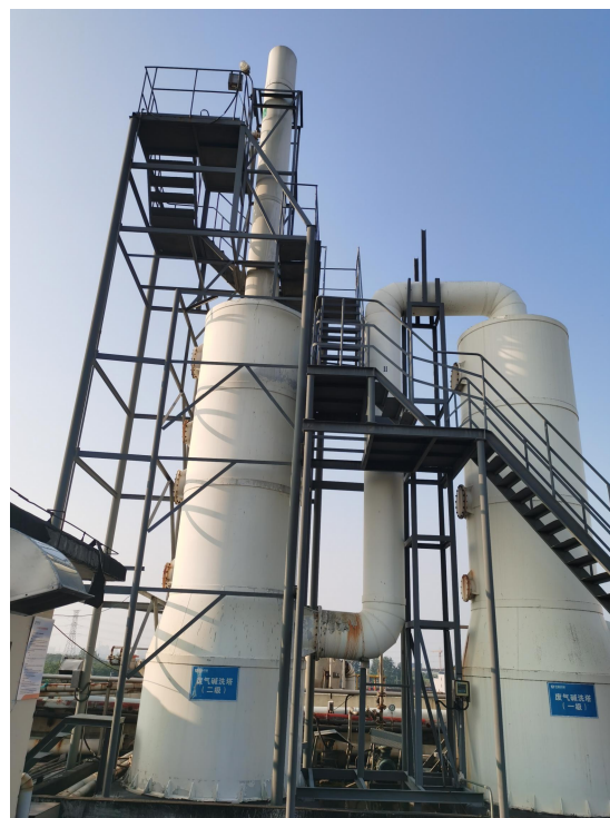
危废库废气处理装置
