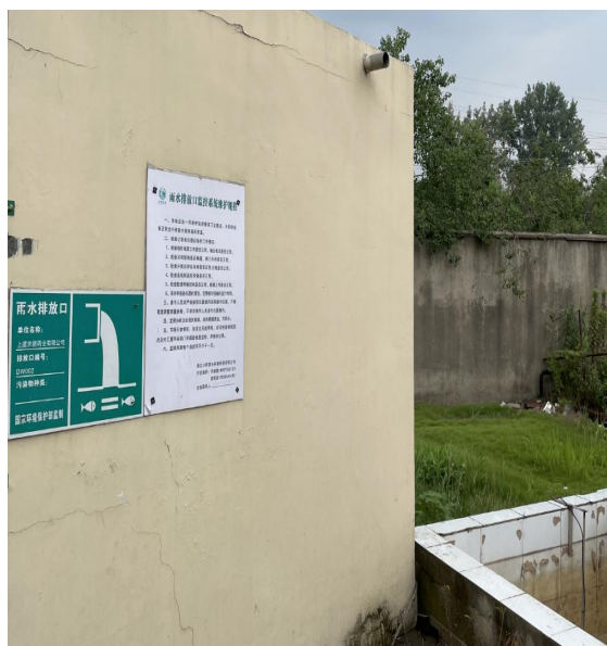
行政楼北雨排口 DW002
