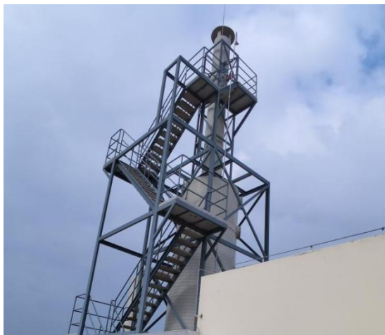
512 车间排放口 DA020
