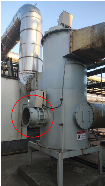
RTO 装置应急新风口，日常封闭状态，不补新风
